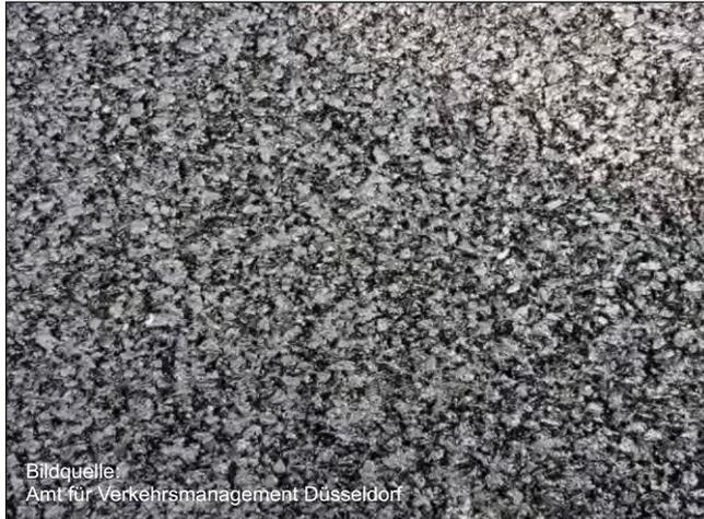
**Beispiel Oberfläche lärmoptimierter Asphalt**
